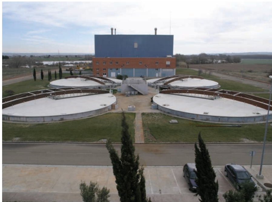
Espesadores e incineración fangos. EDAR LA CARTUJA- ZARAGOZA. Cortesía de Antonio Silva.
