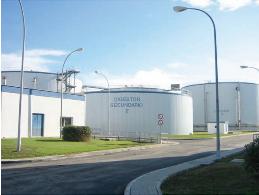
Digestión Anaerobia. EDAR Copero (Sevilla). Cortesía de EMASESA.
