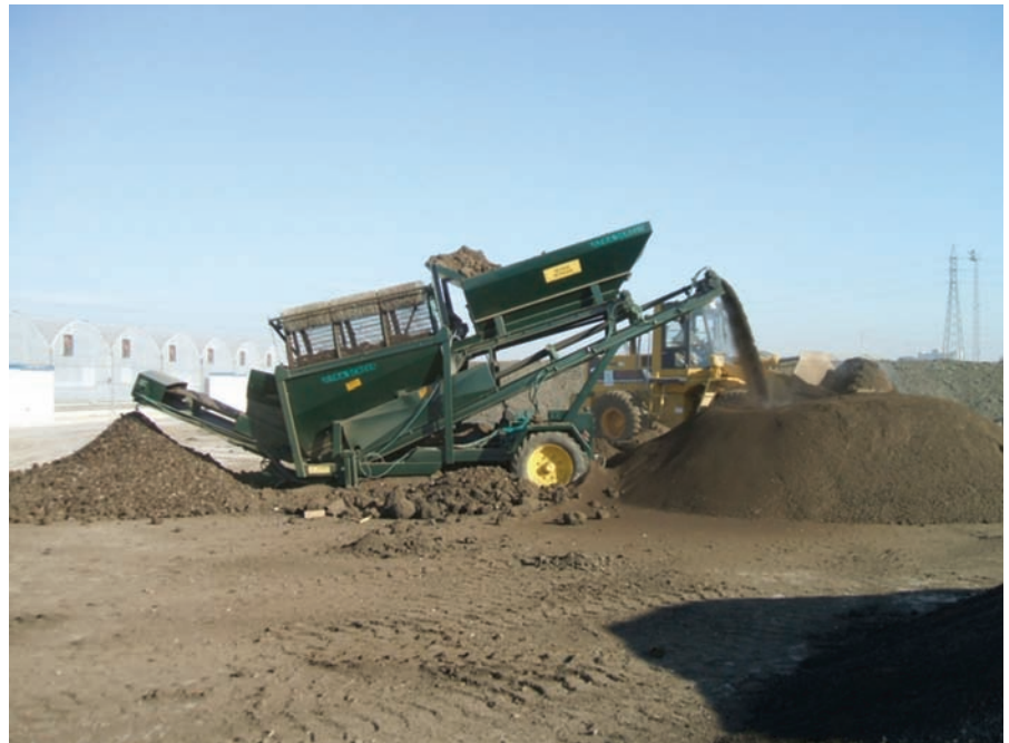
Línea de afino de compost. EDAR de Copero (Sevilla). Cortesía de EMASESA.
