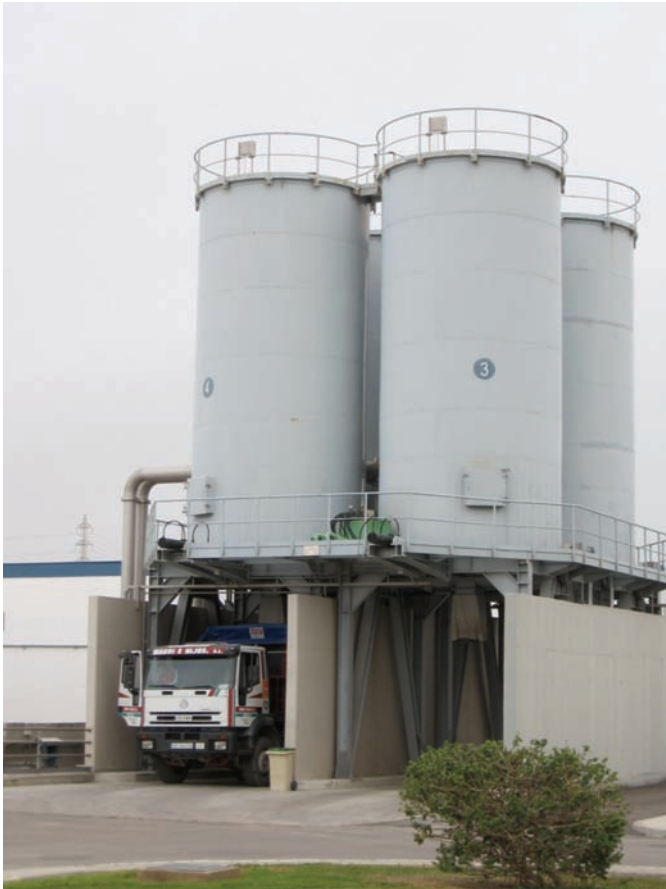
Silos. EDAR de Copero (Sevilla). Cortesía de EMASESA.
