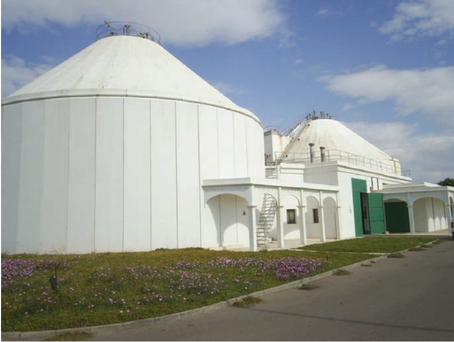
Digestión Anaerobia. AQUALIA EDAR Bobar (Almería). Cortesía de Eduardo Ruiz Guerrero.
