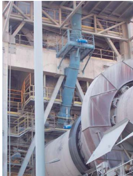
Figura 8.- Conducto de entrada de neumáticos al horno.
